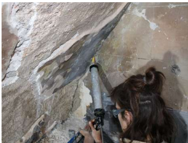
Injecció de morter amb pistola a l'esquerda | volta 4 | Fotografia de Alba Morell
