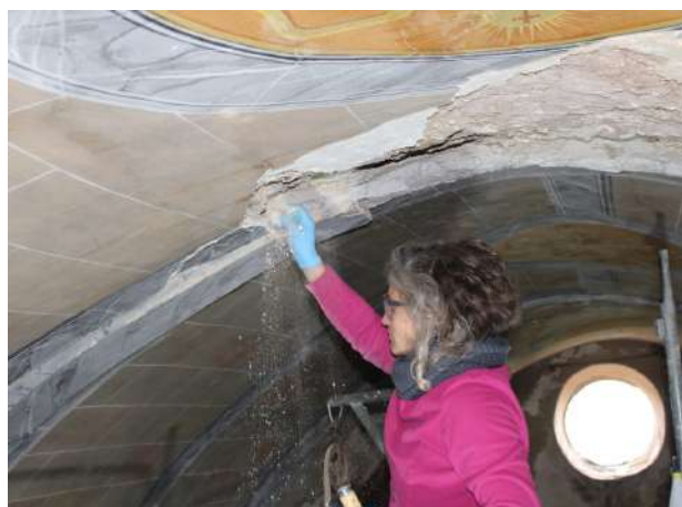
Estat pulverulent dels morters antics | llacuna gran volta 2 | Fotografia de Núria Jutglar
