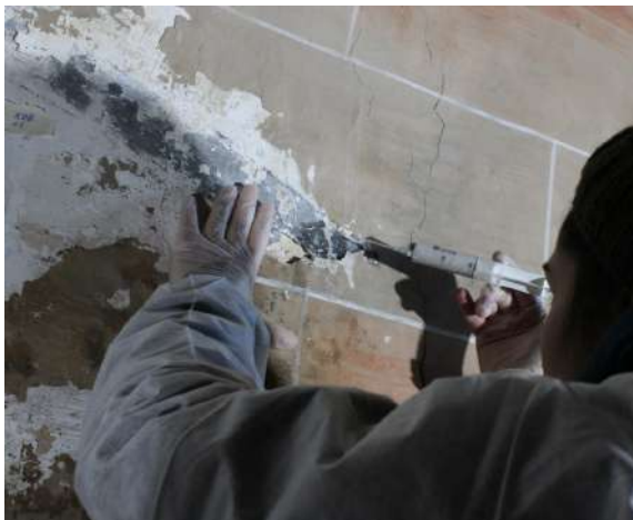
Proves de consolidació d'estrats per injecció | Fotografia de Alba Morell
