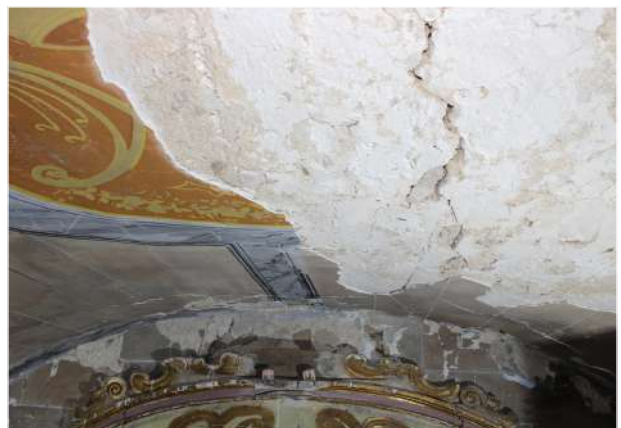
Detall d'una de les grans pèrdues de capa de preparació creant una gran llacuna de policromia | zona central de la Volta 1 | Fotografia de Alba Morell
