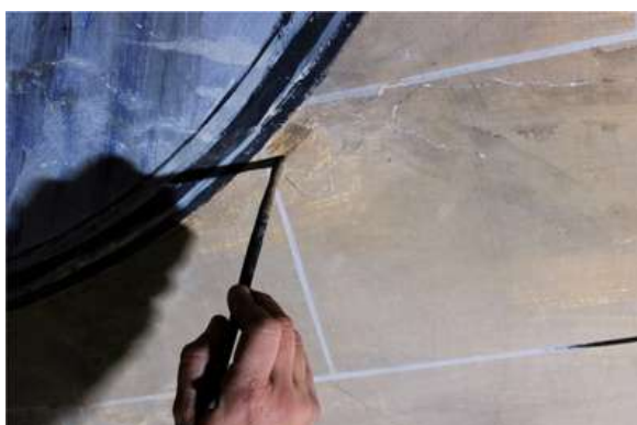
Reintegració il·lusionista de petites pèrdues i fissures | volta 3 | Fotografia de Alba Morell
