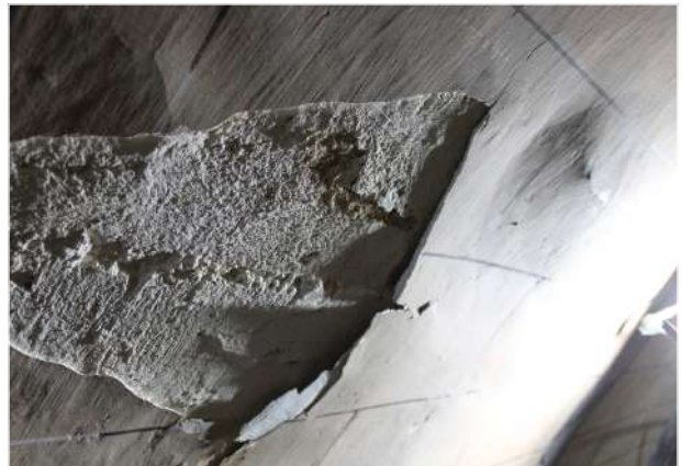
Descohesió de la capa de preparació de guix amb l'estrat subjacent. | zona nord de la Volta 1 | Fotografia de Núria Jutglar i Alba Morell
