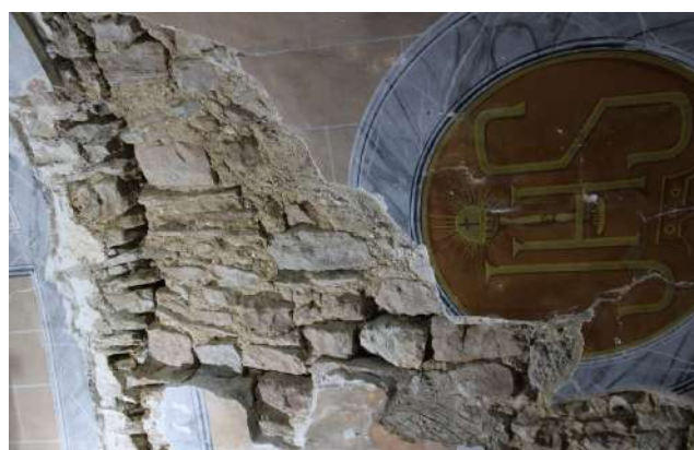
Esquerda gran que connecta amb la llacuna després del sanejament | volta 2 | Fotografia de Alba Morell
