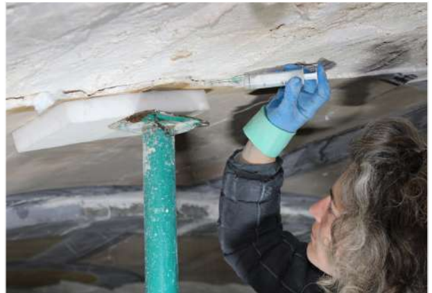
Sistema de puntals i procés de consolidació | Zona central de la Volta 1 | Fotografia de Núria Jutglar
