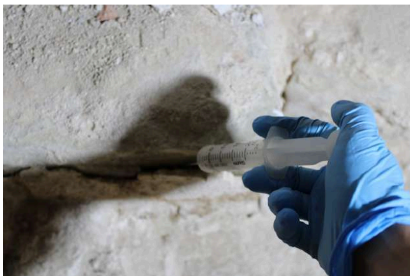
Procés de consolidació per injecció | altar quadrangular de l'absidiola sud | Fotografia de Núria Jutglar
