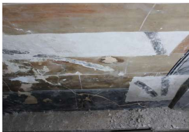
Realització de cales de gran format de les pintures del S.XVIII | Zona sud de la volta 3 | Fotografia de Alba Morell
