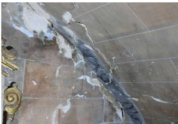
Desplacats múltiples i continus a l'esquerra de l'entrega de la volta amb el parament de l'altar | Fotografia de Alba Morell
