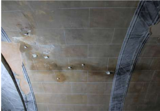
Aureoles de la zona injectada | zona nord de la Volta 2 | Fotografia de Alba Morell
