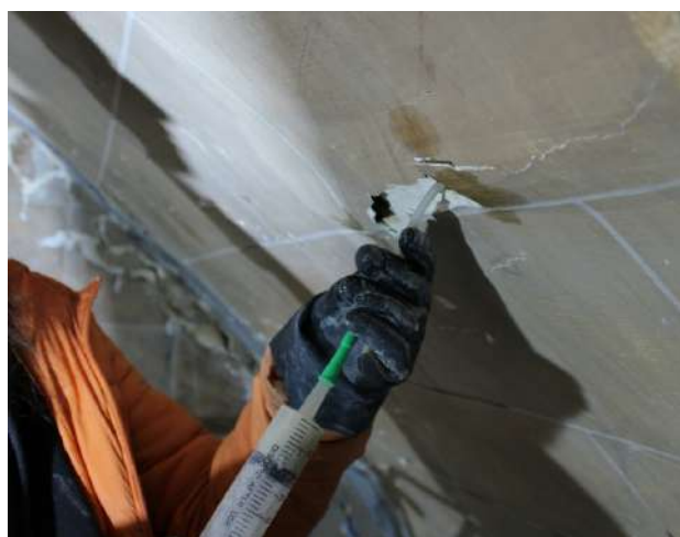
Injecció de morter amb catèter de silicona | zona nord volta 1 | Fotografia de Alba Morell
