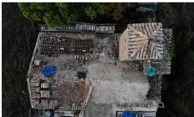
Les dues fases constructives de la teulada que es van veure durant la rehabilitació de 2021 (a la dreta, lloses romàniques) | Fotografia: Associació Sant Julià d'Úixols
