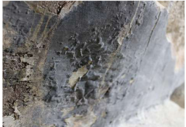
Butllofes del suport pictòric del S.XIX provocades per l'incendi. | zona nord de la Volta 4 | Fotografia de Alba Morell
