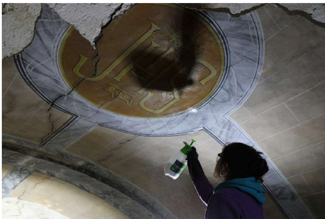
Fixació de policromia amb polvoritzador | Zona central dela Volta 2 | Fotografia de Alba Morell
