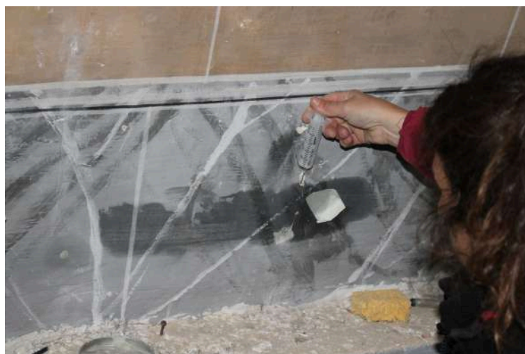
Consolidació per injecció| Zona nord de l'inferior de la Volta 2 | Fotografia de Alba Morell
