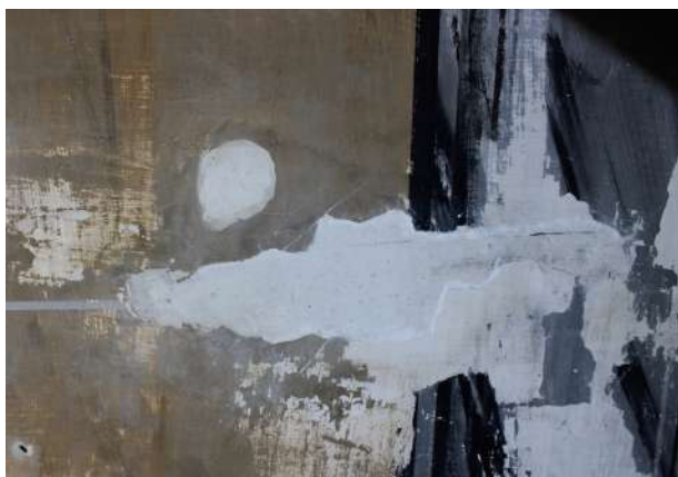
Bisellat i consolidació de llacunes i fissures petites amb calç amarada | volta 1 | Fotografia de Alba Morell
