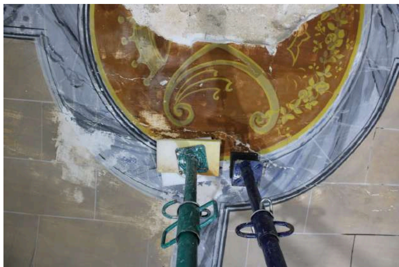
Sistema de puntals durant el procés de consolidació| Zona central de la Volta 1| Fotografia de Alba Morell
