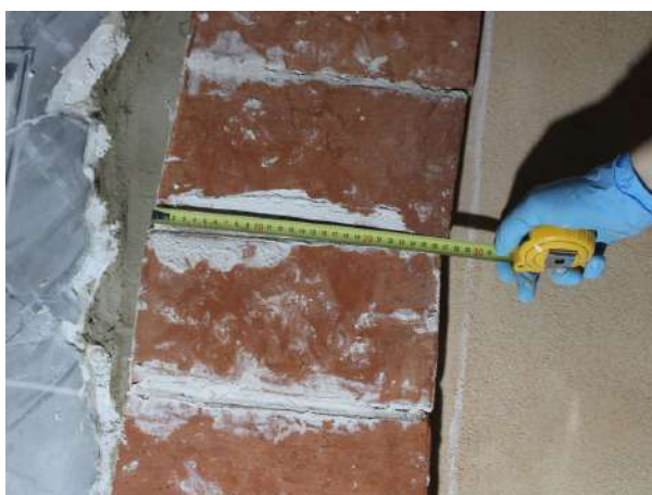
Mesura per igualar els laterals de l'arc amb morter | volta 2-3 | Fotografia de Alba Morell
