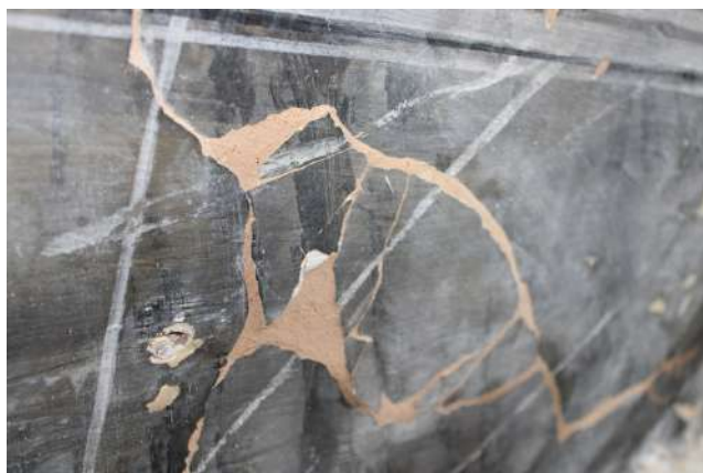
Tancament de fissures amb el morter d'acabat | volta 4 | Fotografia de Alba Morell
