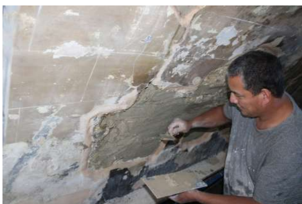
Aplicació de morter per part de paleta | volta 4 | Fotografia de Alba Morell
