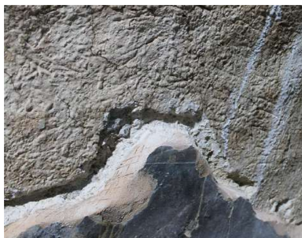
Detall del bisell i perímetre de seguretat a la llacuna gran | volta 4 | Fotografia de Alba Morell
