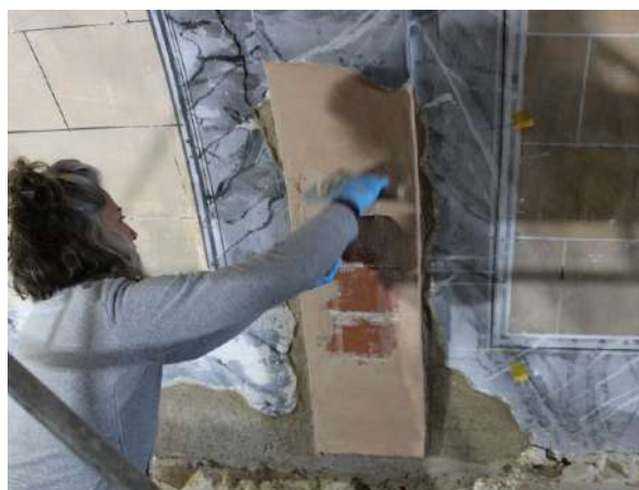
Aplicació del lliscat d'acabat sota nivell | volta 1-2 | Fotografia de Alba Morell
