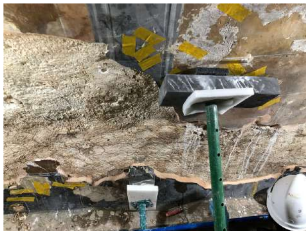
Sistema de puntals i bisellat de llacuna | zona sud de la Volta 4 | Fotografia de Núria Jutglar
