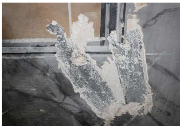
Detall de l'arrencament dels dos encintats del S.XVIII | zona sud de la Volta 3 | Fotografia de Alba Morell
