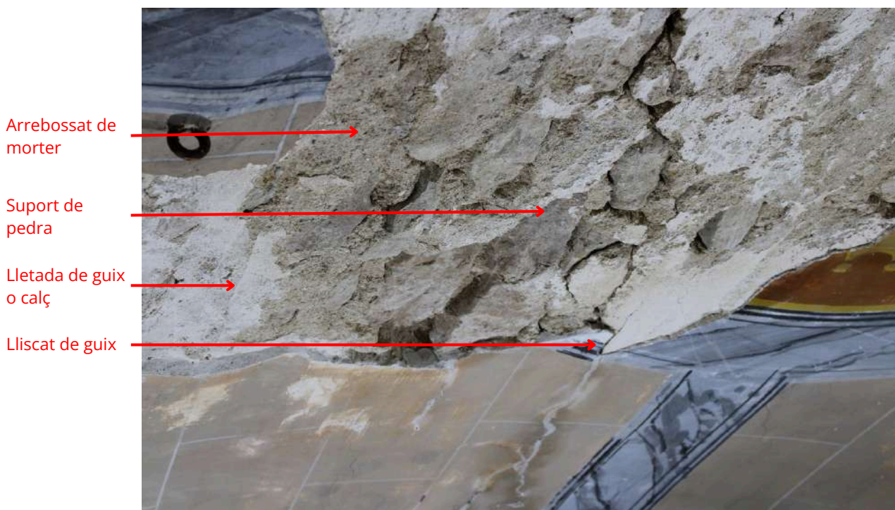
En vermell, senyalització de les capes que formen part de la capa de suport i preparació | Volta 1 | Fotografia de Alba Morell
