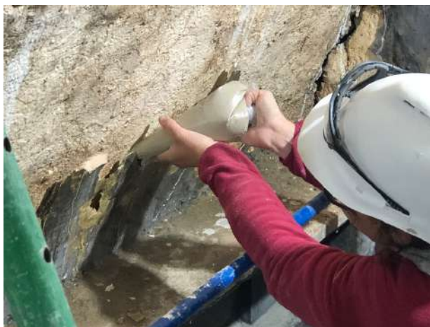
Segellat amb morter de calç i sorra | zona sud de la Volta 4 | Fotografia de Núria Jutglar
