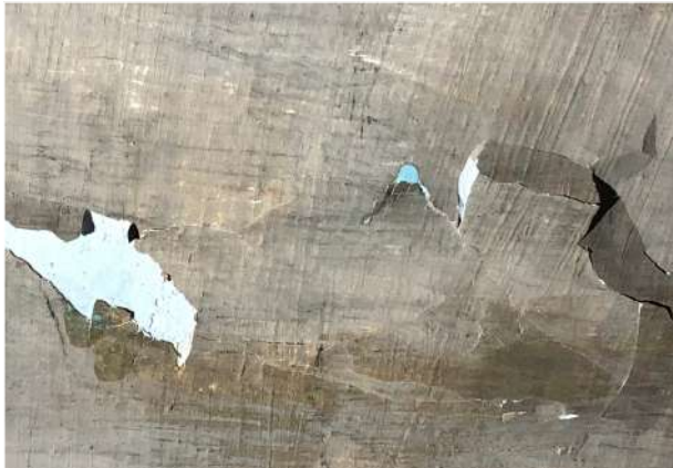
Aixecaments i pèrdues dels estrats pictòrics del s.XIX (capa pictòrica i preparació) | zona sud de la Volta 1 | Fotografia de Núria Jutglar
