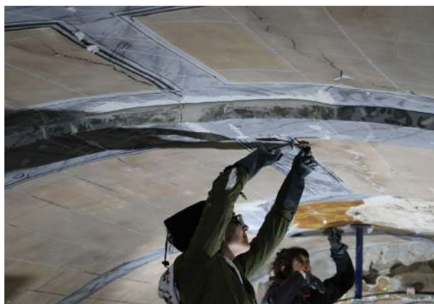
Procés d'injecció | zona central Volta 1 | Fotografia de Alba Morell
