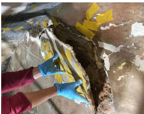
Colocació de gran placa amb morter | mur de l'òcul a la volta 4 | Fotografia de Núria Jutglar
