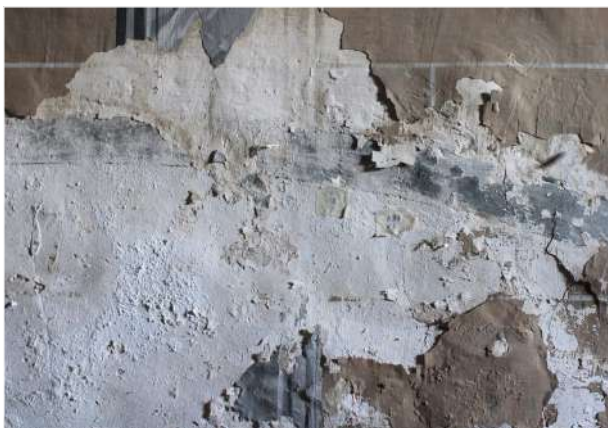
Eflorescències salines puntuals | zona sud de la volta 3 | Fotografia de CRBMC
