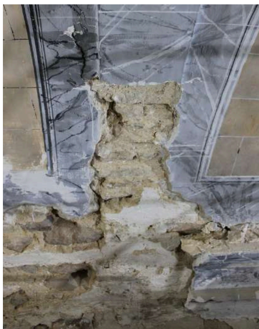
Pèrdua de suport a l'arrencada d l'arc faixó | volta 1-2 | Fotografia de Alba Morell
