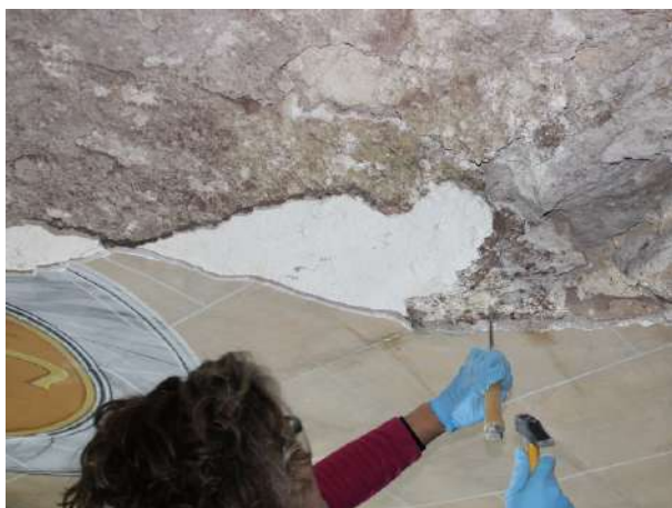
Procés de sanejament de morters antics | llacuna gran volta 2 | Fotografia de Núria Jutglar
