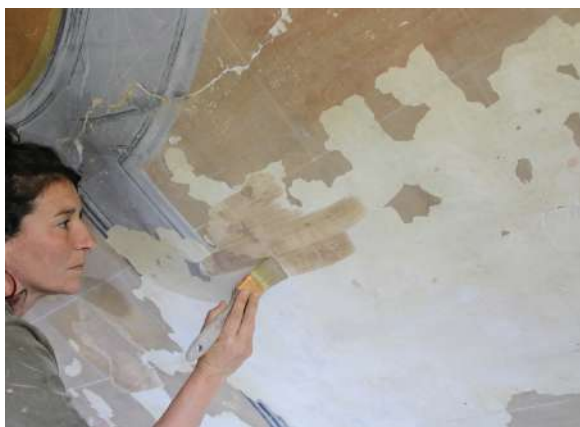
Primera capa de pintura a la calç en llacuna amb pèrdua de capa pictòrica | volta 4 | Fotografia de Alba Morell
