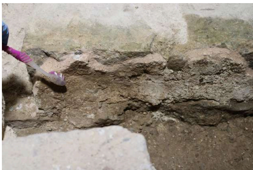
Procés de neteja mecànica dels morters originals | altar quadrangular de l'absidiola sud | Fotografia de Núria Jutglar
