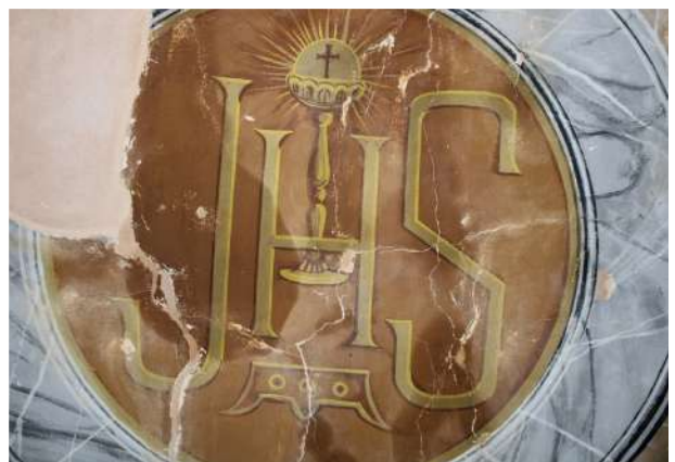
Aureoles de la zona injectada | zona central de la Volta 2 | Fotografia de Alba Morell
