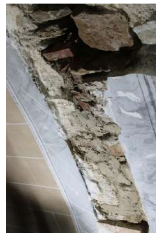
Consolidació d'esquerdes amb morter de calç i fragments de totxo | volta 2 i 4 | Fotografia de Alba Morell
