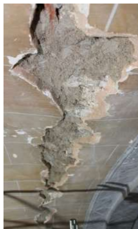
Consolidació d'esquerdes amb morter de calç i fragments de totxo | volta 2 i 4 | Fotografia de Alba Morell
