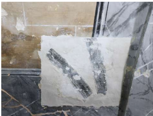
Massilat de les pèrdues amb guix, abans de la reintegració cromàtica | volta 3 | Fotografia de Alba Morell
