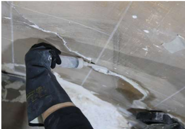
Procés paral·lel d'injecció i bisellat de l'esquerdal zona sud de la volta 1 | Fotografia de Alba Morell
