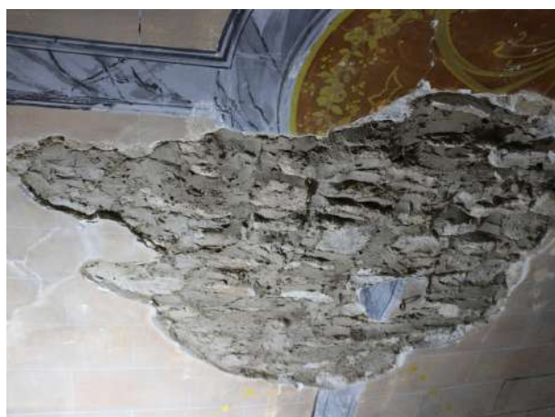
Primera capa amb morter de calç a la llacuna | volta 1 | Fotografia de Alba Morell
