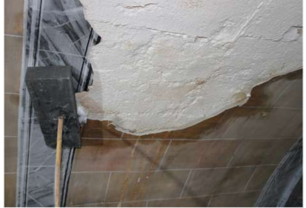
Aureoles de la zona injectada i puntal flexible | zona nord de la Volta 2 | Fotografia de Alba Morell
